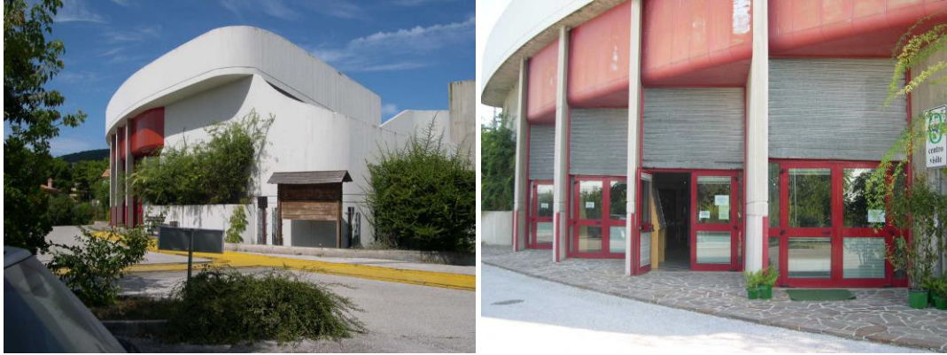
La struttura (lato sud) e l'accesso principale
